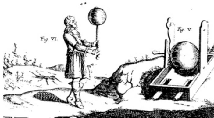
Generador de electricidad de Otto von Guericke; funcionaba con electricidad estática.
